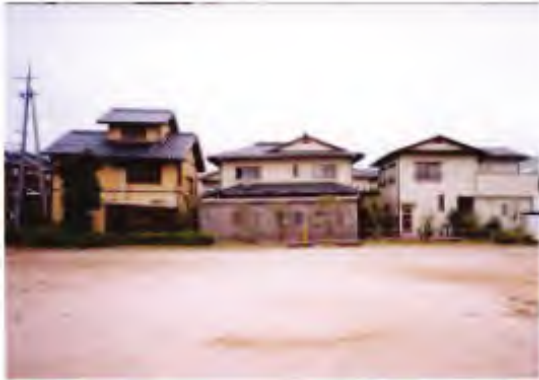
写真-1.15 住宅の傾斜 1-12)
