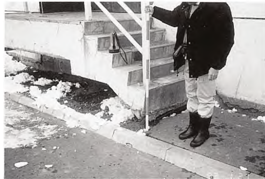
写真-1.6 マンホールの浮き上がり 1-8) 写真-1.7 液状化による敷地の沈下 1-8)
