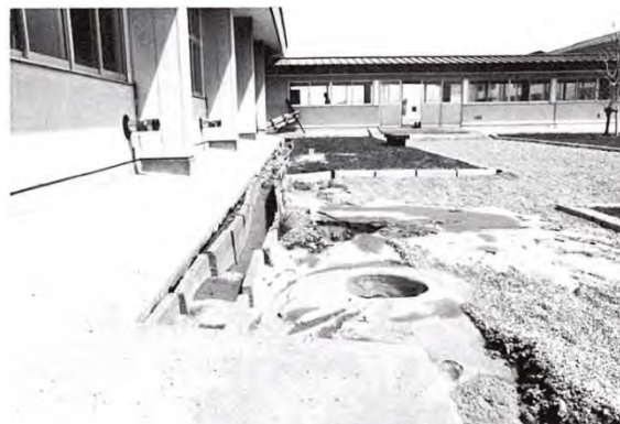
写真-1.5 男鹿工業高校での噴砂の様子 1-7)
