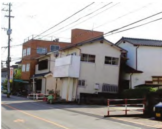
写真-1.31 傾斜した住宅 1-21)
