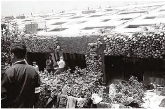
写真-1.1 液状化によるアパートの転倒 1-5)
