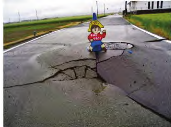
写真-1.29 テニスコートで発生した噴砂 1-20) 写真-1.30 浮き上がったマンホール 1-20)
