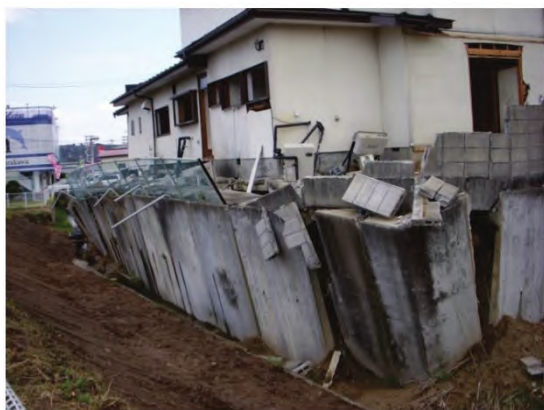
写真-1.25 盛土の液状化による住宅被害 1-17)
