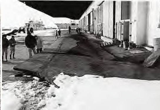
写真-1.8 道路・歩道での噴砂 1-8) 写真-1.9 釧路港での沈下・亀裂 1-8)
