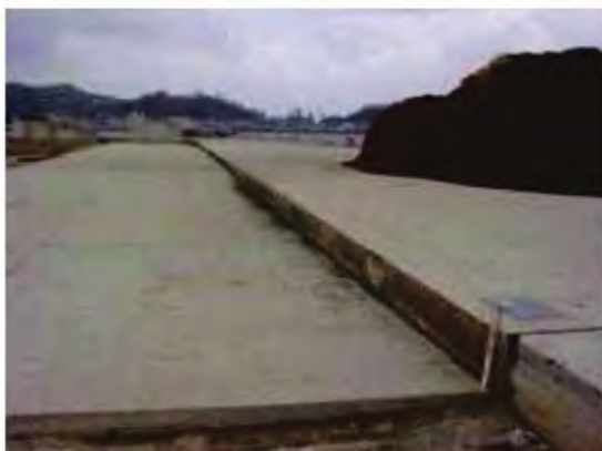
写真-1.22 輪島港におけるエプロンの沈下 1-15)
