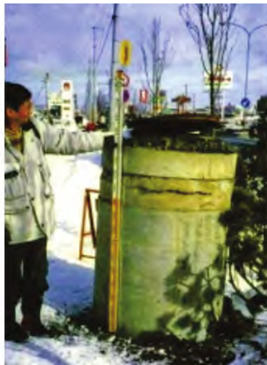
写真-1.6 マンホールの浮き上がり 1-8) 写真-1.7 液状化による敷地の沈下 1-8)
