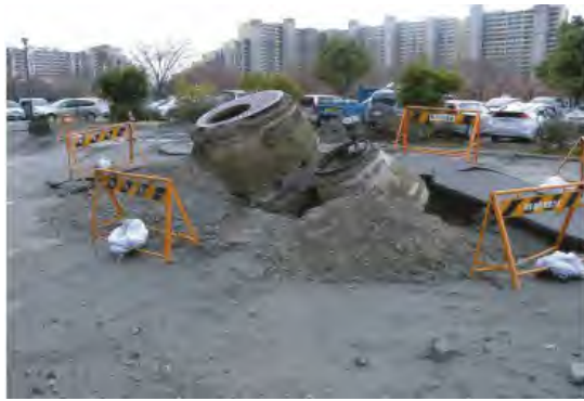
写真-1.27 液状化によるマンホールの浮上 1-19)
