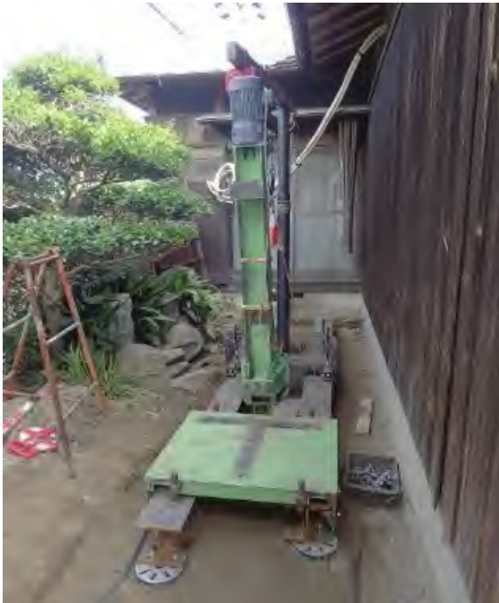
写真-1.36 小型回転圧入装置 1-36)
