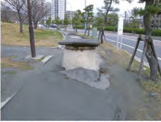
写真-1.27 液状化によるマンホールの浮上 1-19)
