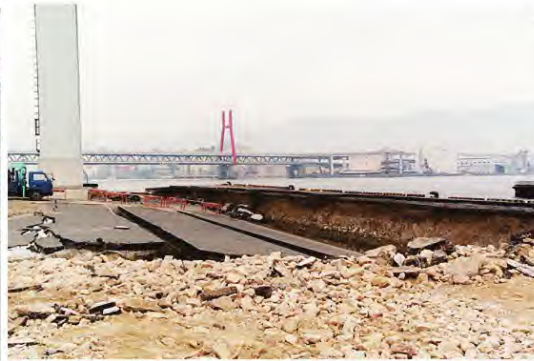
写真-1.13 大開通における道路の変形 1-11) 写真-1.14 六甲アイランドの護岸の変形 1-11)
