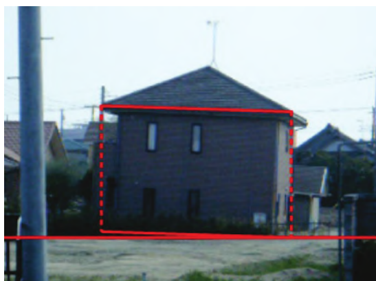
写真-1.26 液状化による住宅の傾斜 1-18)
