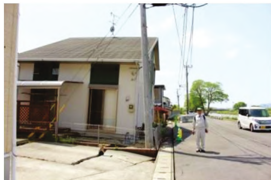
写真-1.31 傾斜した住宅 1-21)
