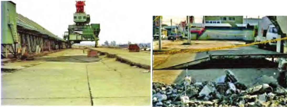
写真-1.3 秋田港エプロンの様子 1-7) 写真-1.4 ガソリントankの浮上 1-7)
