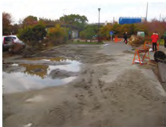
写真-1.28 液状化による噴砂 1-19)
