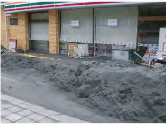
写真-1.28 液状化による噴砂 1-19)
