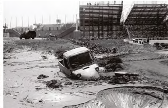
写真-1.2 陸上競技場内の液状化被害 1-5)
