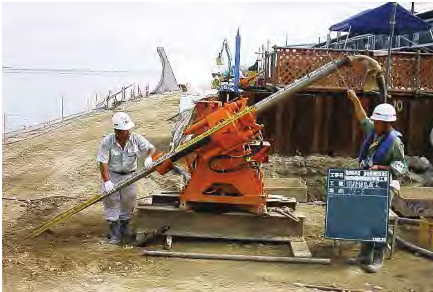
写真-1.35 斜め施工の様子 1-31)
