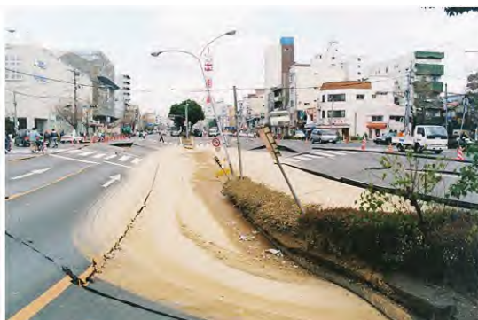
写真-1.13 大開通における道路の変形 1-11) 写真-1.14 六甲アイランドの護岸の変形 1-11)
