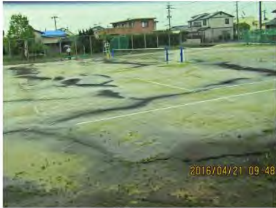
写真-1.29 テニスコートで発生した噴砂 1-20) 写真-1.30 浮き上がったマンホール 1-20)
