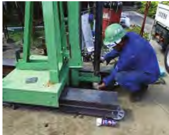
写真-1.37 ドレーン圧入施工 1-36)
