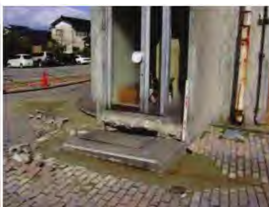
写真-1.23 建物周辺地盤の沈下 1-15)
