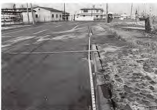
写真-1.8 道路・歩道での噴砂 1-8) 写真-1.9 釧路港での沈下・亀裂 1-8)
