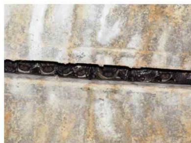
高架橋の隙間をねぐらにしていたヒナコウモリ (2015年7月7日、岐阜市、長野浩文撮影)
