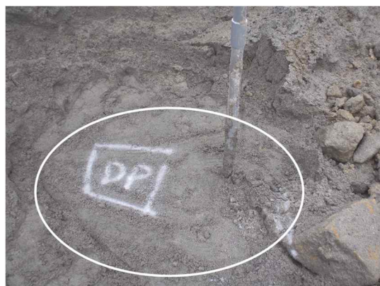
写真-4.14 二重管ダブルパッカ工法改良体
