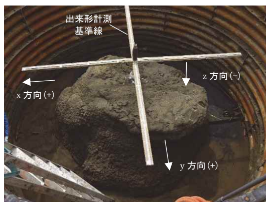
写真-4.5 掘削した改良体
