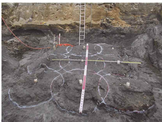
写真-4.13 改良体の掘削全景
