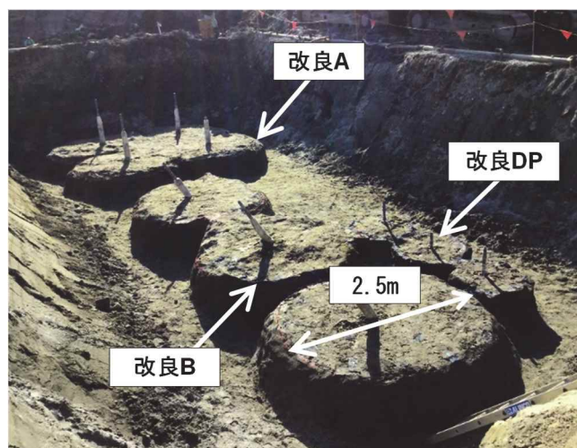
写真-5.4 改良体発掘写真（発掘深度 GL-3m）
