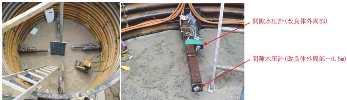
写真-4.4 間隙水圧計設置状況
