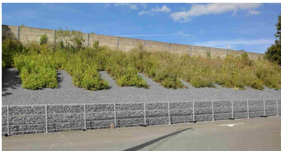
図-6.2 砕石縦排水工の施工後の状況
