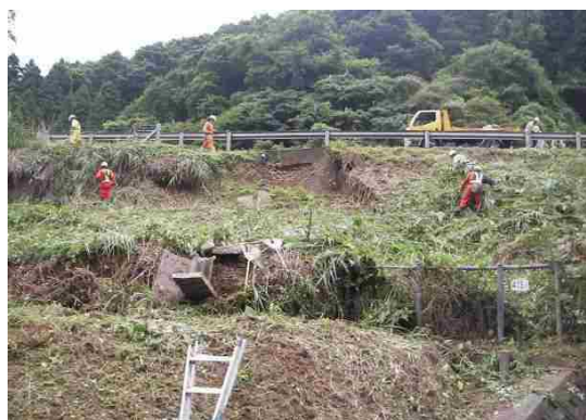
図-3.50 のり面の表層崩落
