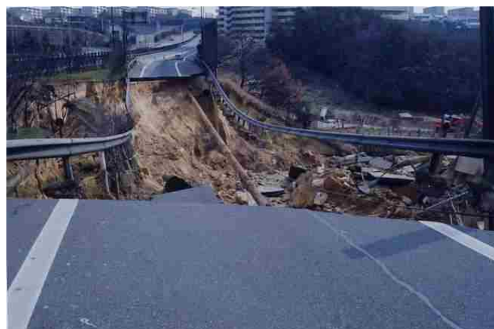
図-3.25 第二神明大蔵谷 IC 盛土崩壊状況
