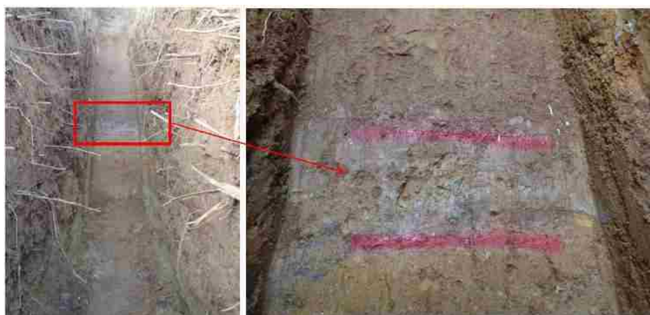
図-6.16 開削時の湧水状況
