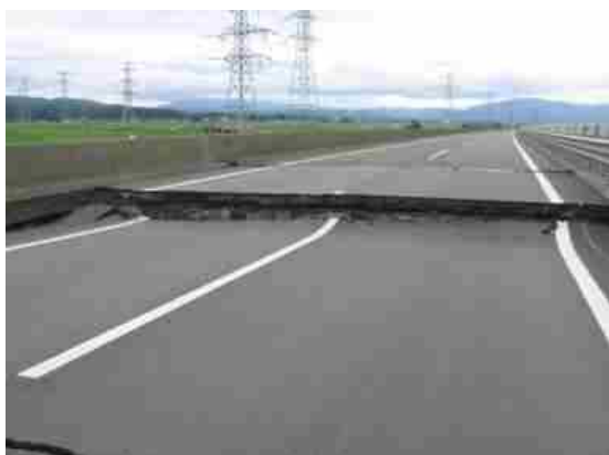
図-3.47 構造物取付け部の段差
