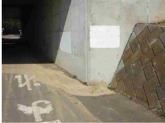
図-4.27 盛土材料の流出状況 14)
