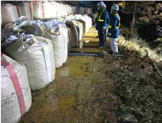
図-4.26 仮復旧箇所からの湧水状況 12)
