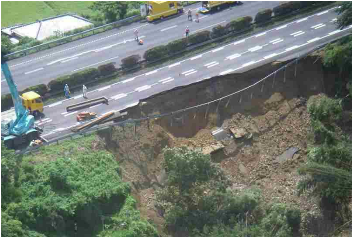
図-3.63 盛土のり面の崩壊状況
