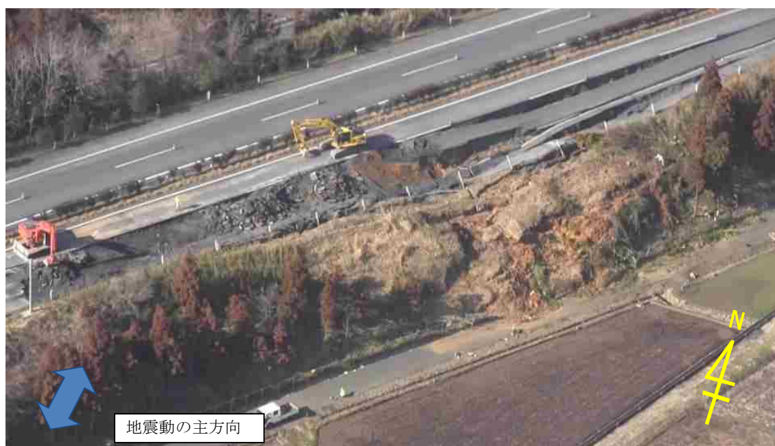
図-4.22 常磐自動車道那珂地区の盛土崩壊状況
