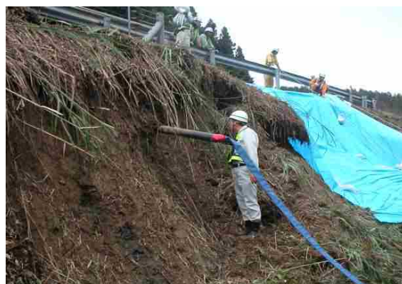
図-3.58 建設時の地下排水工
