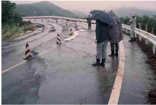
図-3.4 ヘアピンカーブ盛土路面の変状
