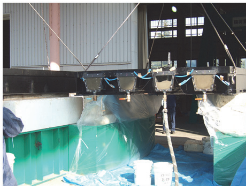
写真 3-8 軽量モルタルの充填状況
