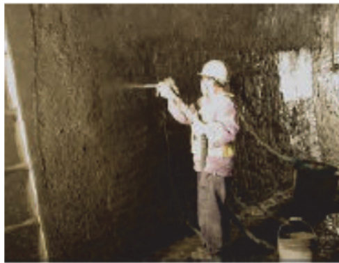
写真 2-7 トンネル内面への施工状況吹付け
