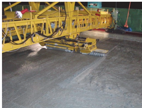
写真 2-8 上面増厚の施工状況（フィニシャーによる仕上げ）
