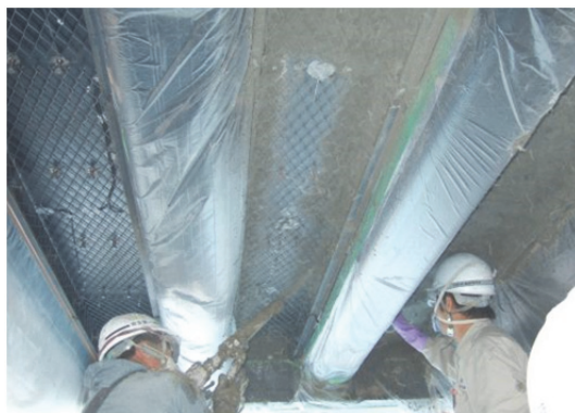
写真 3-2 試験体への HPFRCC 吹付け状況
