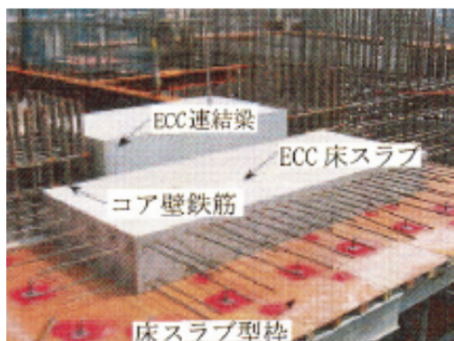
写真 2-13 現場にて設置された ECC 部材
