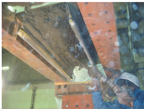
写真 3-3 上向き吹付け状況および仕上げ状況
