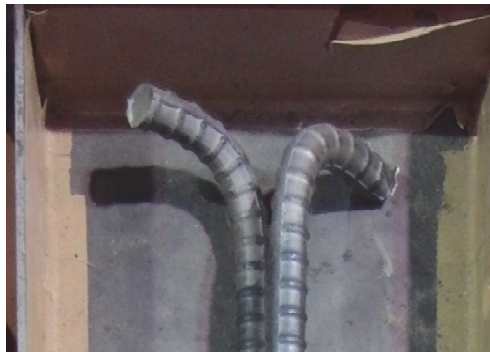
写真 4-10 端部の曲げフックの例
