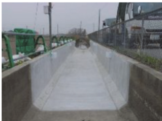
写真 2-1 水路補修 ECC ショット施工例
