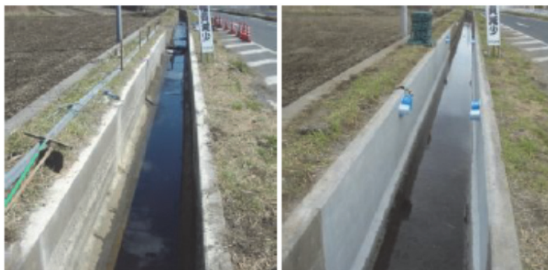
写真 2-2 水戸市での補修例（左：補修前，右：補修後経過観察中）
