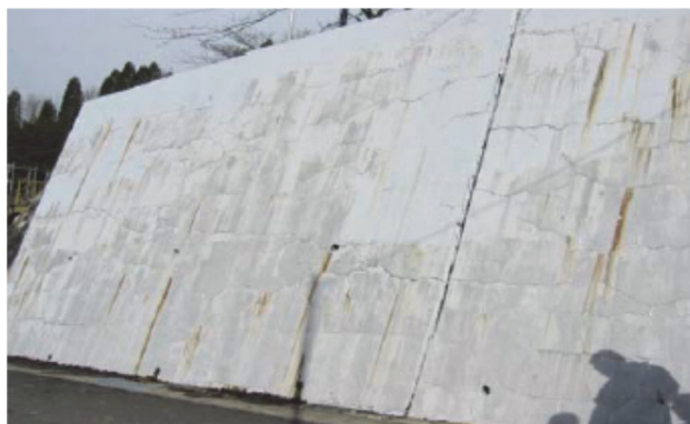
写真 2-12 施工前の擁壁の状況
