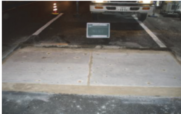
写真 2-14 ノージョイント化工法（舗装前）
