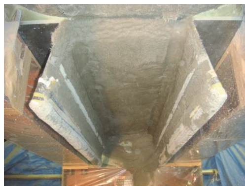
写真 3-3 上向き吹付け状況および仕上げ状況
