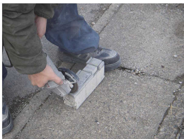
写真-2.7 供試体の切断
