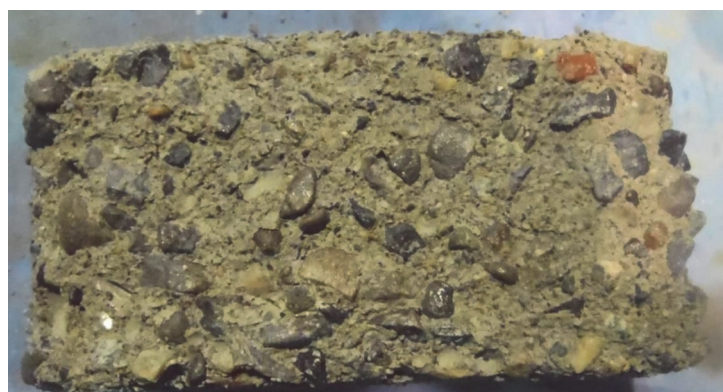
写真-6.9 防水無供試体 (90 サイクル時点 打設面のスケーリング状況)
