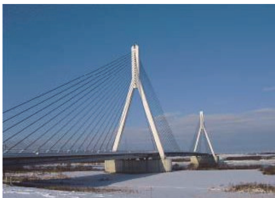
写真-1.2 美原大橋全景
