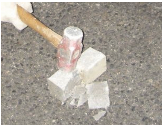
写真-3.3 鉄筋はつり出し
