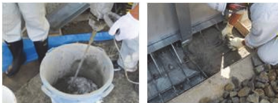
写真-1.10 防音壁保護モルタル施工状況
