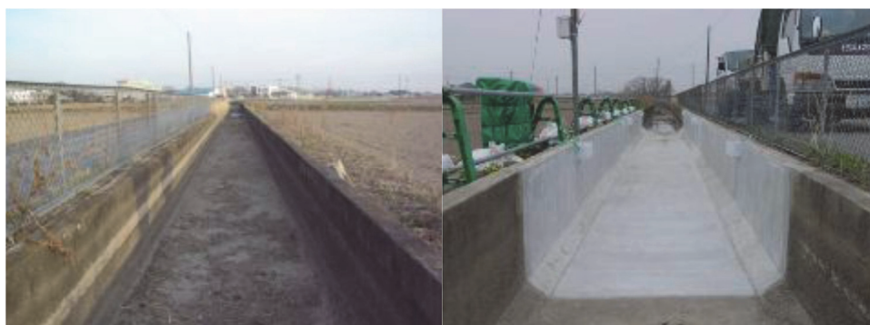
写真-1.8 つくばみらい市での補修事例（左：補修前，右：補修後）
