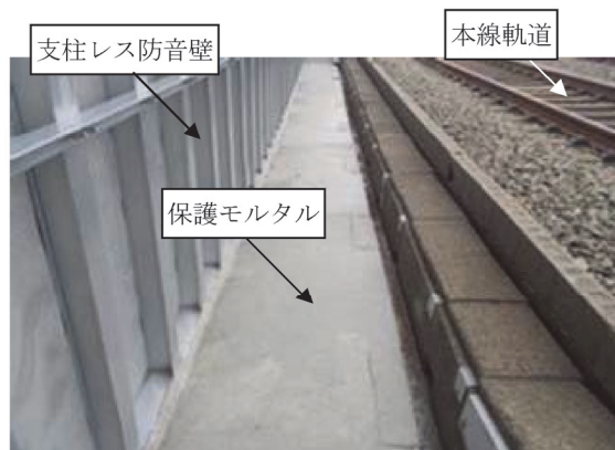
写真-1.9 防音壁保護モルタルの全景
