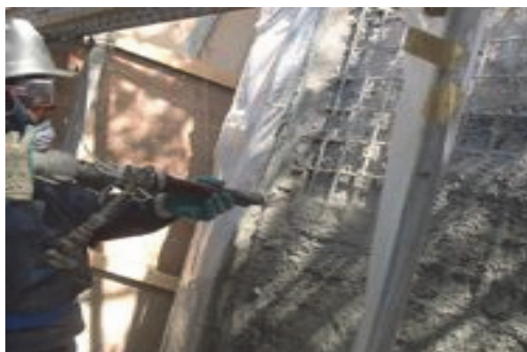
写真－4.1 HPFRCC を用いた吹付け工法
