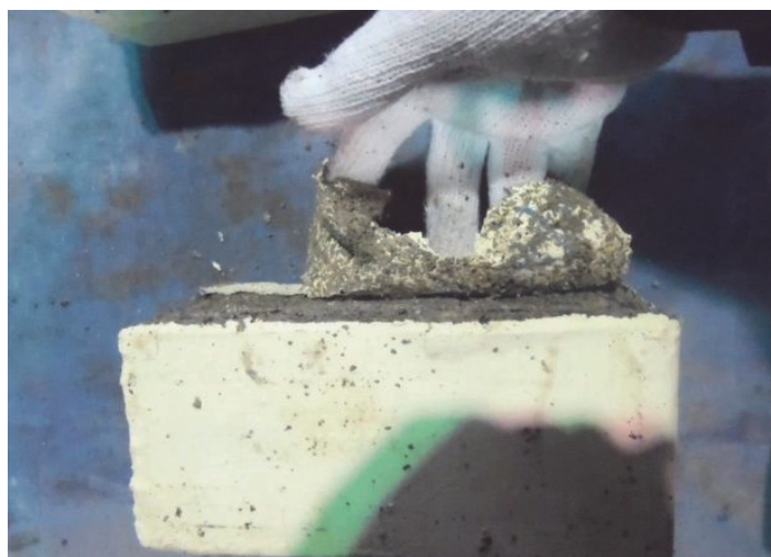
写真-6.8 5面防水供試体 (90 サイクル時点 打設面の塗膜剥がれ)
