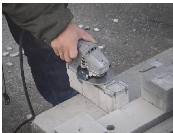
写真-2.8 脆弱部の削り落とし
