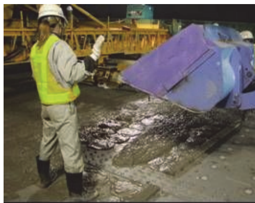
写真-1.3 施工状況
