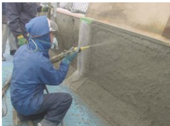
写真-1.7 吹付け ECC 施工状況
