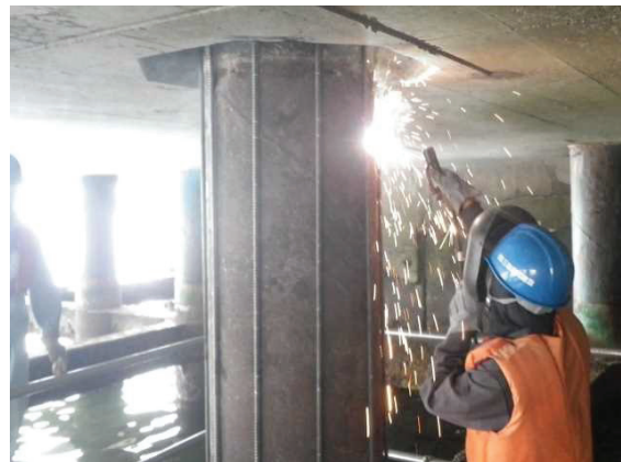
(d) 定着鉄筋溶接工
