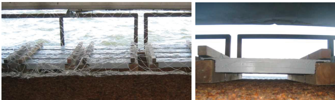
写真-3.1 暴露状況（栈橋下の飛沫帯，暴露面を下向きに設置）
