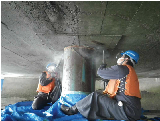
(a) 既設上部工はつり工
