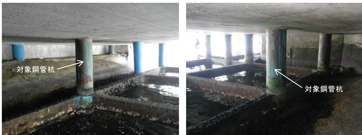
写真-8.9 試験施工対象鋼管杭（施工前）
