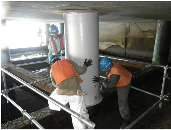
(e) 型枠設置工
