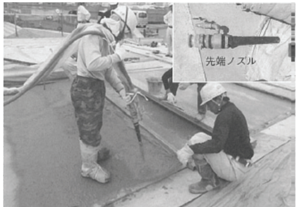
吹付け施工状況
