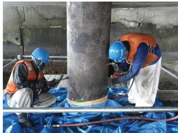
(b) 既設表面被覆材撤去
