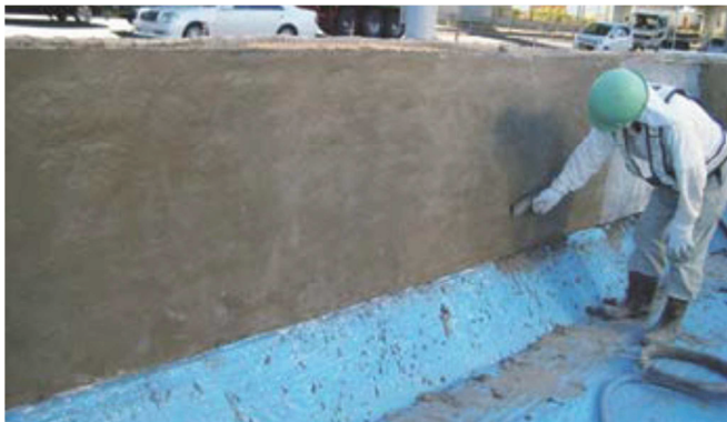
コテ仕上げ施工状況
