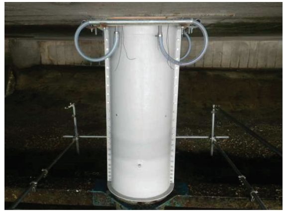
(f) 型枠設置完了
