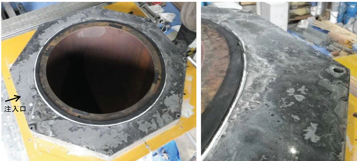
写真-8.6 模擬上部工天端面の充填状況
