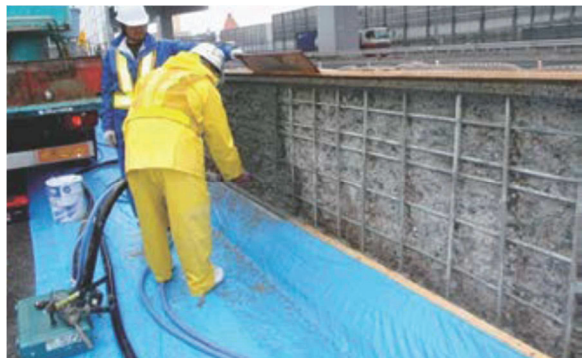
UHP-SHCC の吹付け施工状況
