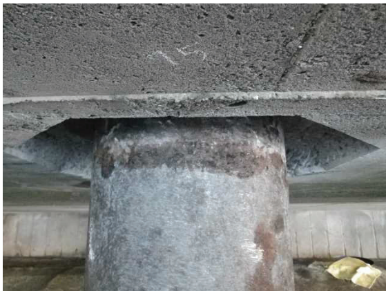
(c) はつり後の杭頭部
