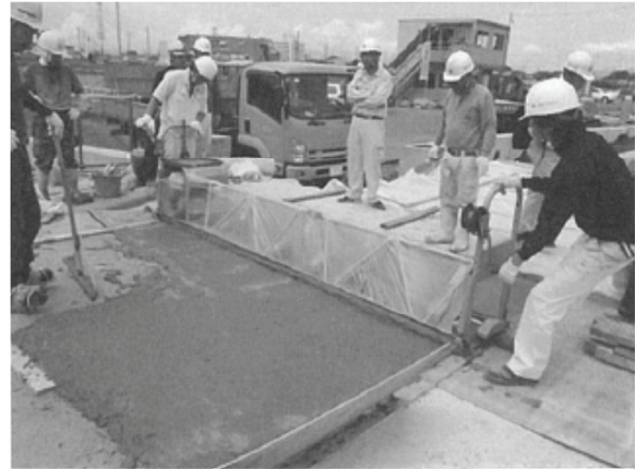
コンクリートフィニッシャーによる施工状況
