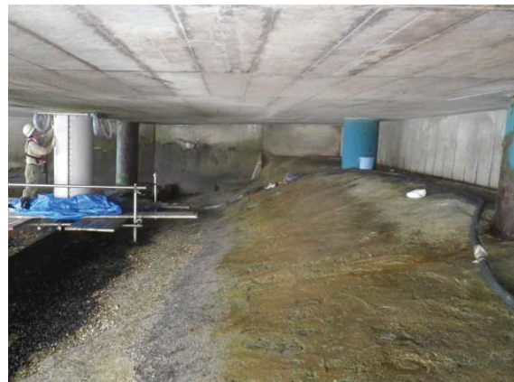
(h) 圧送状況
