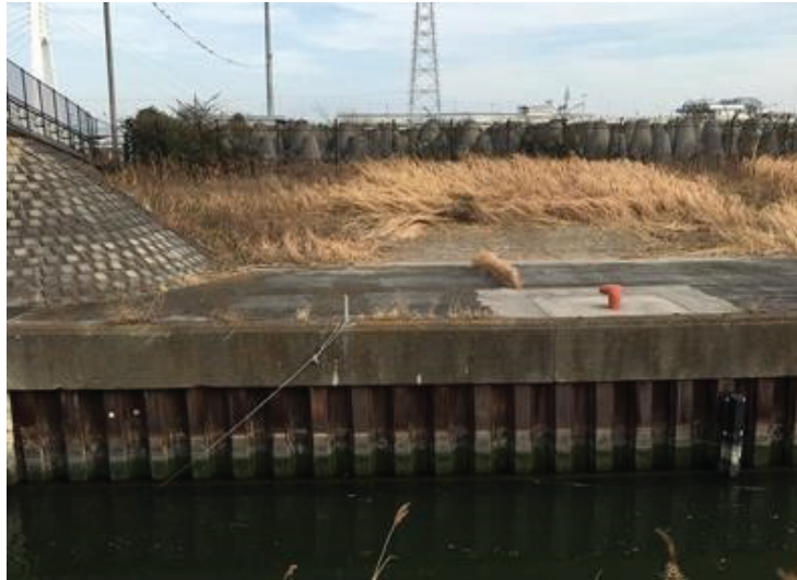
写真5-2-1 コーピング(川崎市多摩川)
