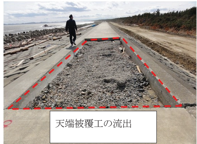
(b) 天端被覆工の流出(宮城県大曲海岸)
