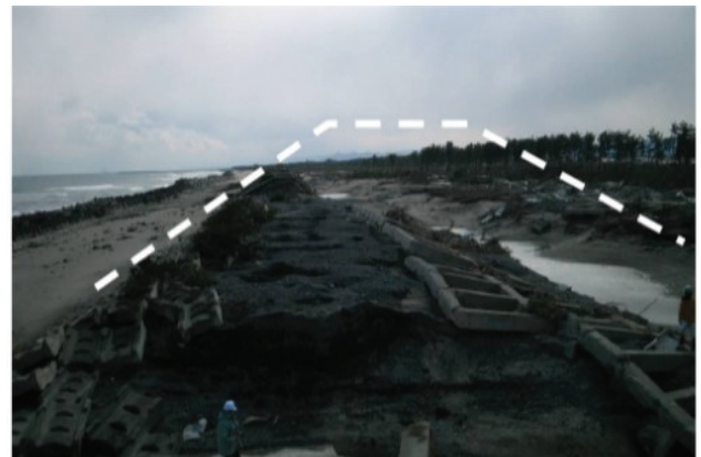
(b) 天端裏のりが削られた海岸堤防
