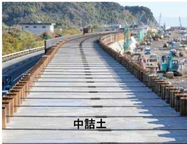
写真 2-6 鋼矢板施工状況 2-8)
