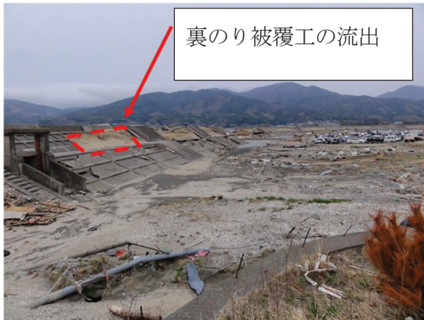
(a) 裏のり被覆工の流出(岩手県金浜海岸)
