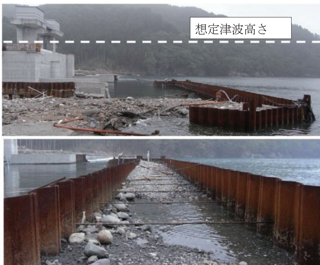
写真 1-3 津波被災後の二重鋼矢板壁 1-18)
