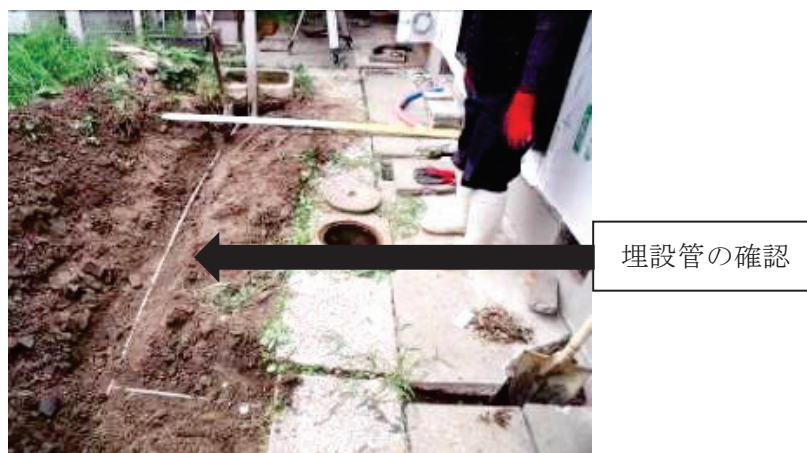
写真 A.3.3 埋設管の確認
