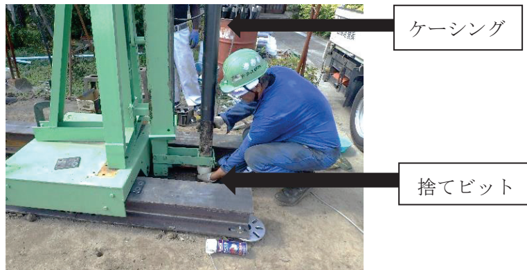
写真 A. 3. 8 取り付けの様子
