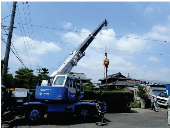
写真 5.9 10t ラフタークレーンによる H型鋼打設状況
