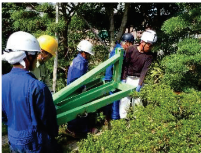
写真 A. 3. 6 小型回転圧入装置の搬入状況
