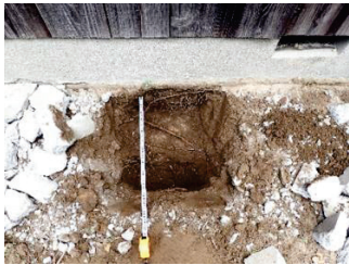
宅地周辺の埋設物の調査
