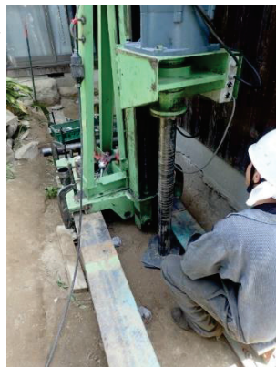
鉛直ドレーン打設
