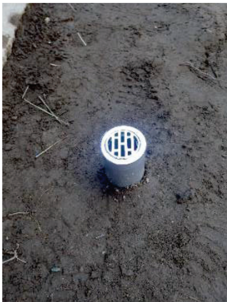
写真 A. 3. 22 空気抜き穴の設置状況
