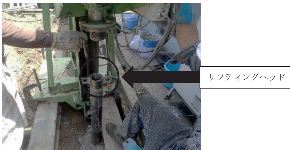
写真 A. 3. 18 ケーシングの引き抜きの様子
