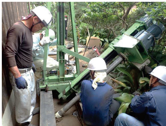
写真 A. 3. 9 斜打ちの様子
