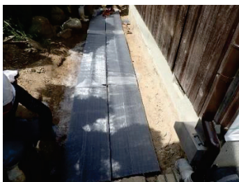
排水マットの敷設
