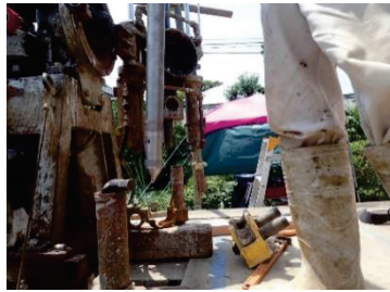
写真 5.5 同左設置作業
