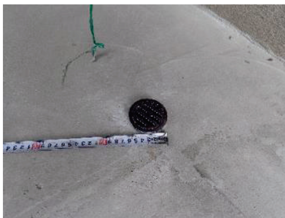
写真 A. 3. 23 コンクリート被覆後の状況
