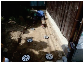
整地と架台設置
