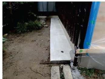
空気抜き穴の設置とコンクリート被覆
