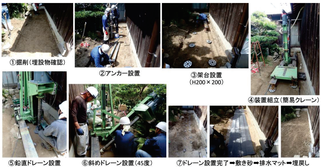
図 5.21 ドレーン敷設の作業手順と施工状況
