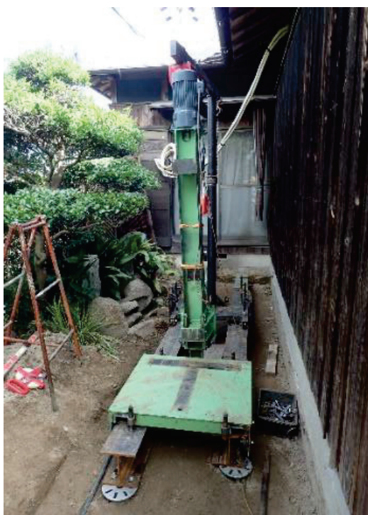
写真 A. 3. 7 小型回転圧入装置の組立状況
