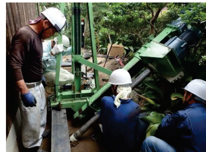
斜めドレーン打設(45度)
