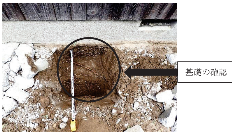
写真 A.3.2 基礎の確認
