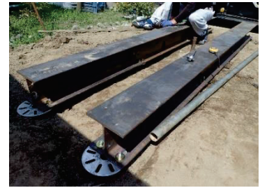
写真 5.6 架台設置 200H型鋼
