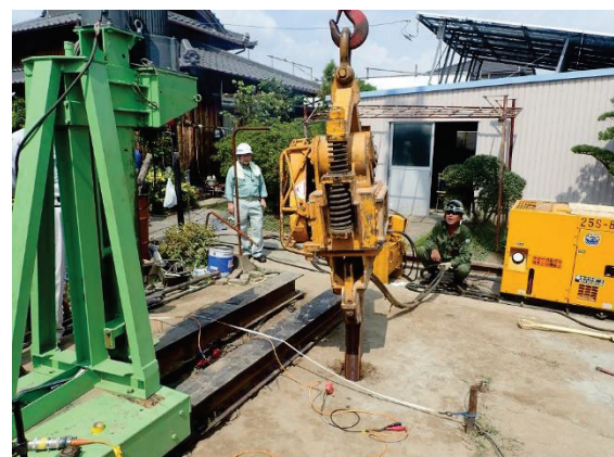
写真 5.10 パイプロによる起振状況 (H型鋼部分改良)
