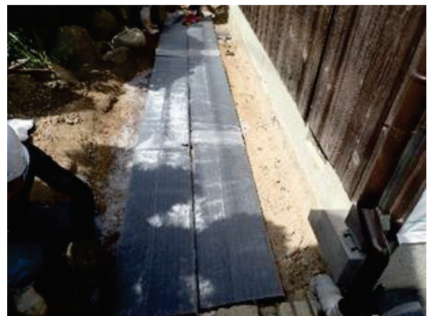
写真 A. 3. 21 ドレーンマット施工時の状況
