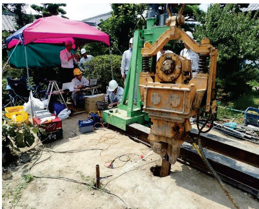
写真 5.11 計測状況(H型鋼部分改良)
