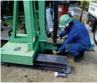
写真 5.7 鉛直ドレーン施工
