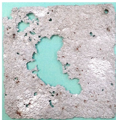
写真 1-2 さび除去後の試験体の状況
