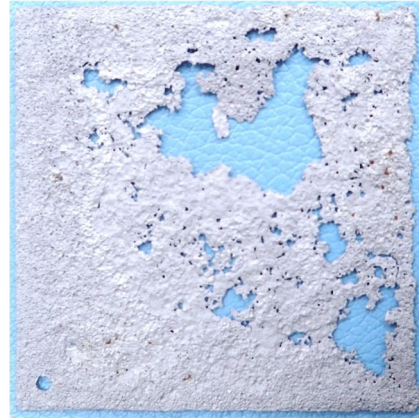
(b) さびの除去後
