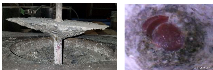
図-3.24 ひび割れ注入補修後のコーン状破壊と孔底の状況 (接着系注入式)
