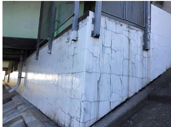
防護柵支柱周辺【1.13】
