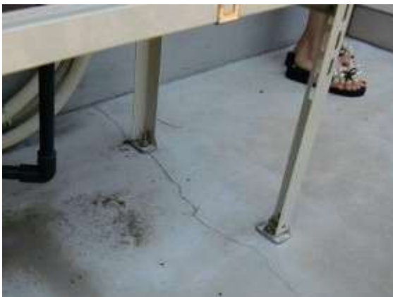
設備支柱周辺【1.13】
