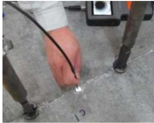
図-2.8 孔内ひび割れ(ETAG 式)
