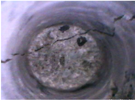
図-2.7 孔内ひび割れ確認状況(ETAG 式)
