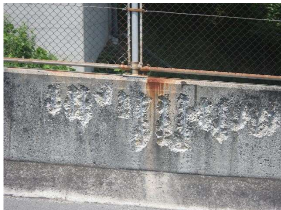
高欄上部柵周辺【1.13】
