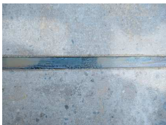
写真-1.3 二次陽極材の塗布直後の状況
