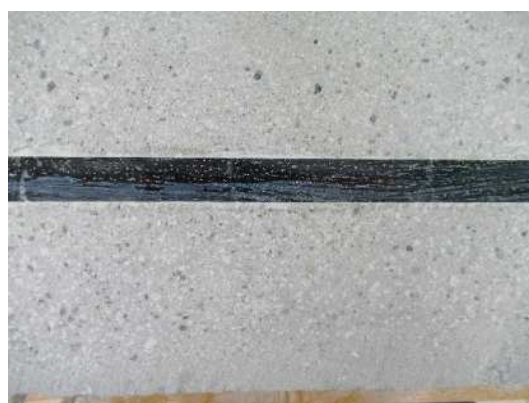
写真-1.4 二次陽極材の乾燥後の状況
