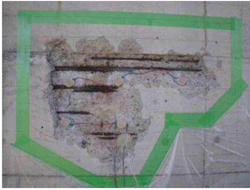
図 3-10 犠牲陽極材設置写真 (A1)
