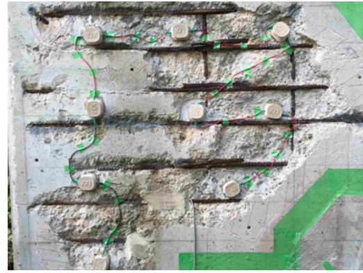
図 3-11 犠牲陽極材設置写真 (A2)
