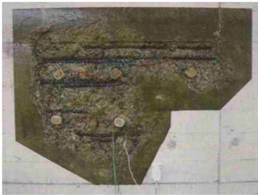
図 3-12 防水材塗布後 (A1)
