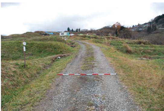
写真 4-4 砂利舗装農道(幅員 2.5m程度)
