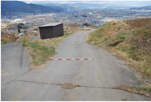
写真 4-2 コンクリート舗装農道(幅員 2.5m以上)
