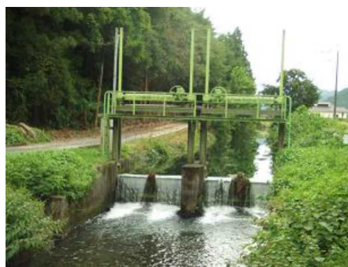
Fig.2-9 管瀬川下流部の水門
