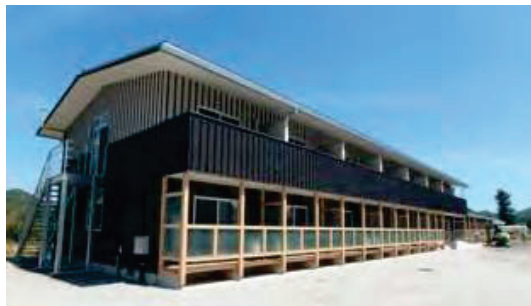
高知県四万十町 宿舎（H28.5 竣工） 2 階建て・1 棟
