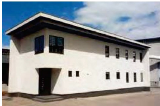
北海道北見市 研修施設（H27.3 竣工） 2 階建て・1 棟
