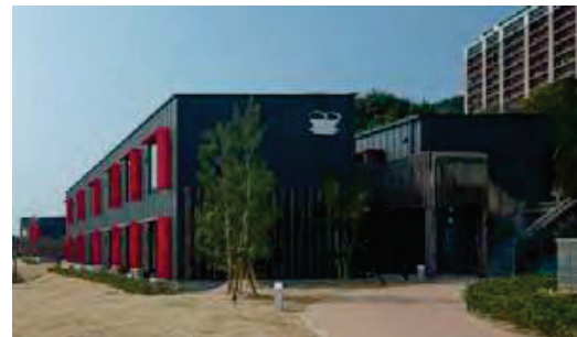
長崎県佐世保市 ホテル（H28.2 竣工） 2 階建て・6 棟
