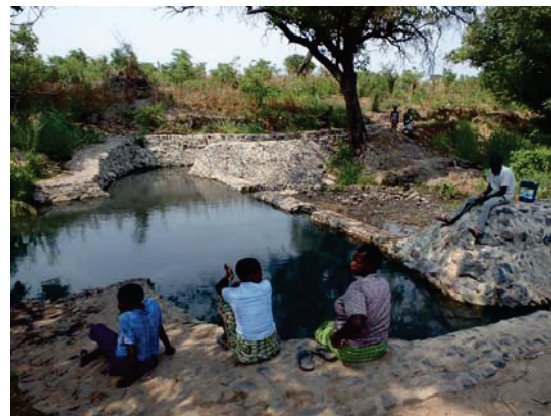
写真 2.4 恒久堰（粗石練積み）、左岸取水（左）、両岸取水（右）
