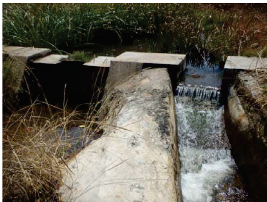
写真 3.2 恒久堰（コンクリート）
