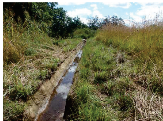
写真 3.3 粗石練積み水路(始点部)
