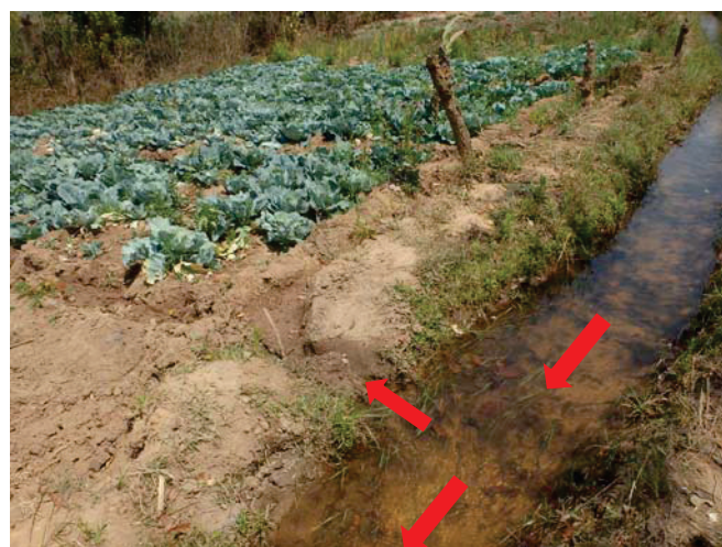
写真 3.6 水口（直接分水）
