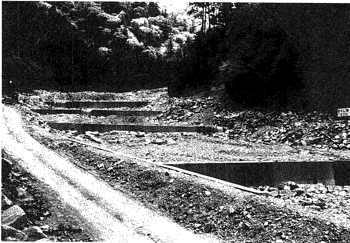
写真1 低ダム群施工区間 溪岸に転石が積み上げられている。
