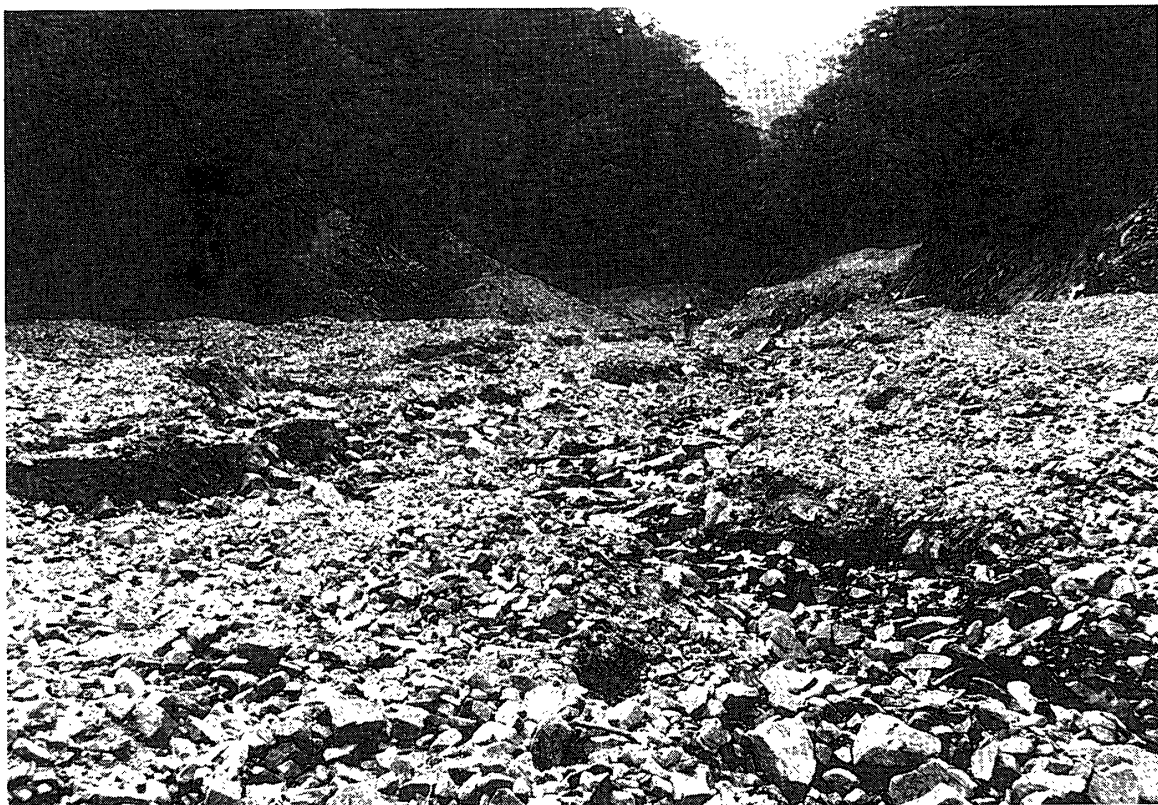
写真3 土石流出後の第④遊砂地 後続流による洗掘が顕著である。
