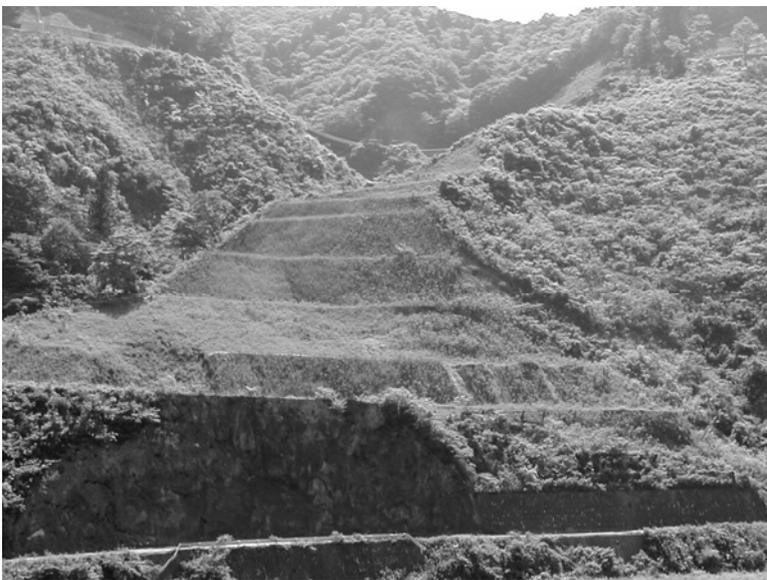
写真-1-2 吹付け後3年経過時の斜面
