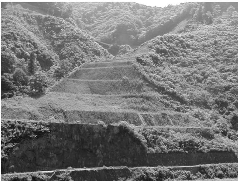
写真-1-2 吹付け後3年経過時の斜面
