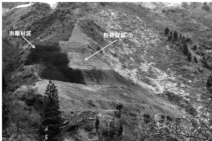
写真-1-1 緑化吹付け斜面
