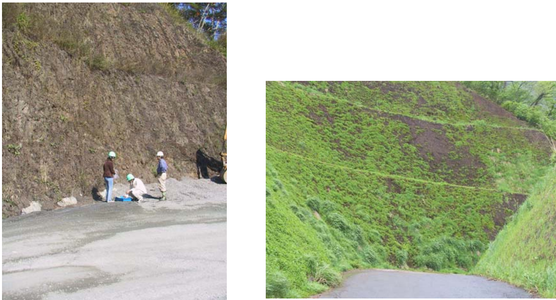
図 4-1 調査対象となったチップ吹付け法面
