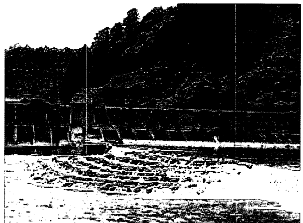
図1: 根尾川に設置された棚田式魚道
