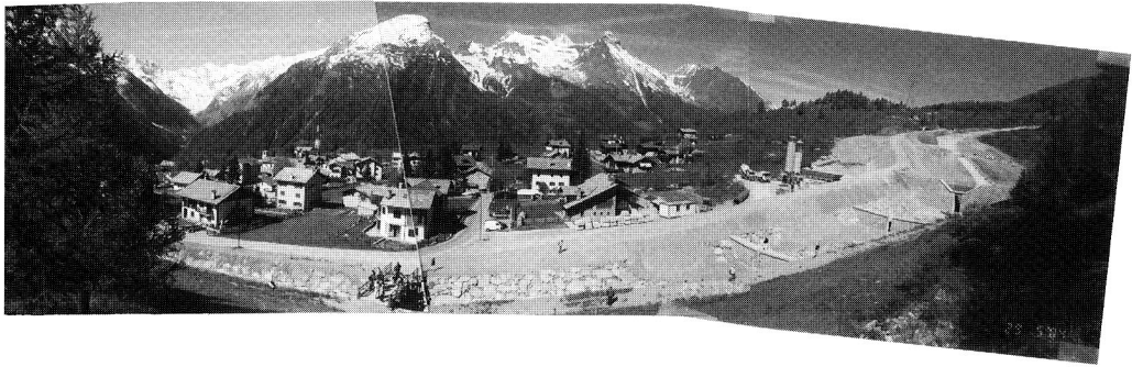
写真-3 Gimilian 渓流の流路工及び上部砂溜工
