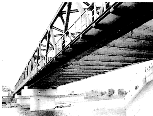
写真-1 SRC床版形式の下路トラス橋
