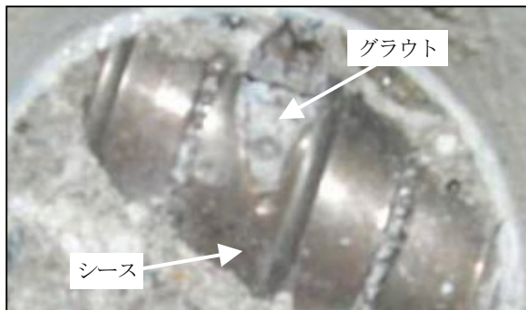
写真10 グラウト充填状況 (下り線耳桁西方面 C2C)
