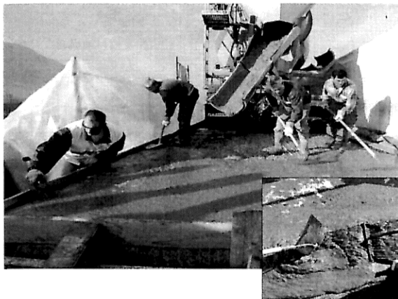
写真3 橋梁の上面増厚に適用されたUHPFRC
