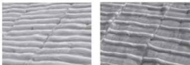
写真-1 誘導型マットによって法面に形成された凹凸
